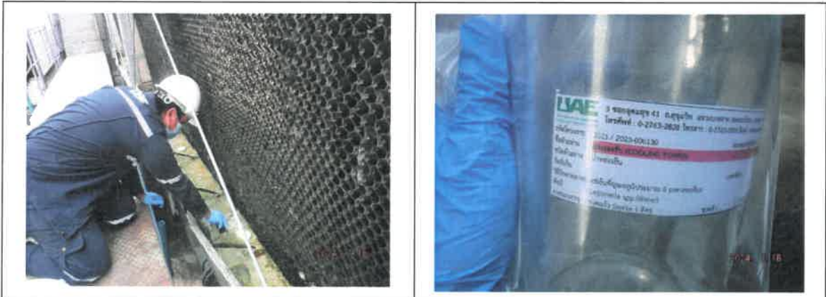
รูปที่ 3-1 การติดตามตรวจสอบคุณภาพน้ำที่เข้าหอผึ่งเย็น บริเวณอ่างรองรับ (Cooling Tower)
